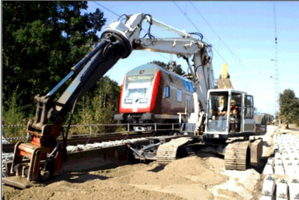
Das Bodenaustauschmaterial muss so gewählt werden, dass auf der Oberkante Bodenaustausch die Forderung  $E_{v2} = 45 \text{ MN/m}^2$  und  $k_f \geq 10^{-4} \text{ m/s}$  erfüllt wird.
